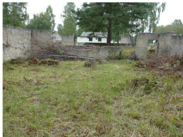
Widok na ścianę wewnętrzną strona północna.
