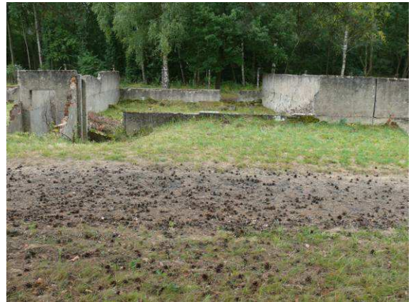
Widok na ścianę zewnętrzną strona północna.
