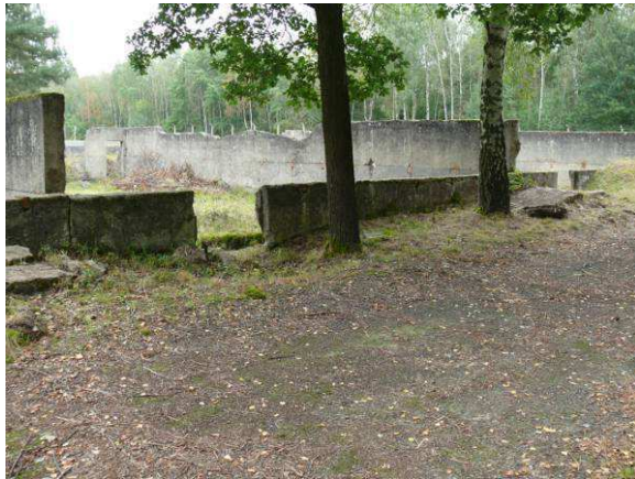
Widok na ścianę zewnętrzną strona południowa.
