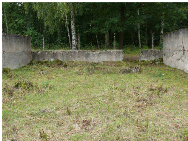
Widok na ścianę wewnętrzną strona południowa.
