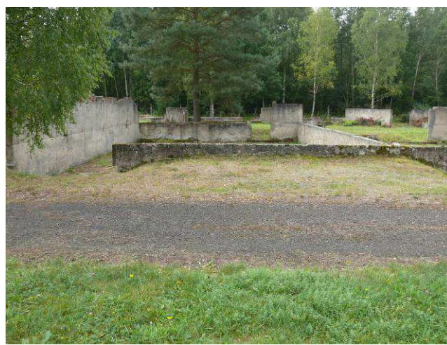
Widok na ścianę zewnętrzną strona północna.
