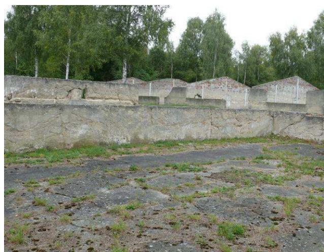
Widok na ścianę wewnętrzną strona zachodnia.
