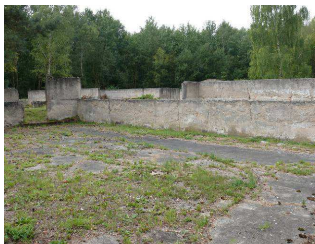
Widok na ścianę wewnętrzną strona zachodnia.
