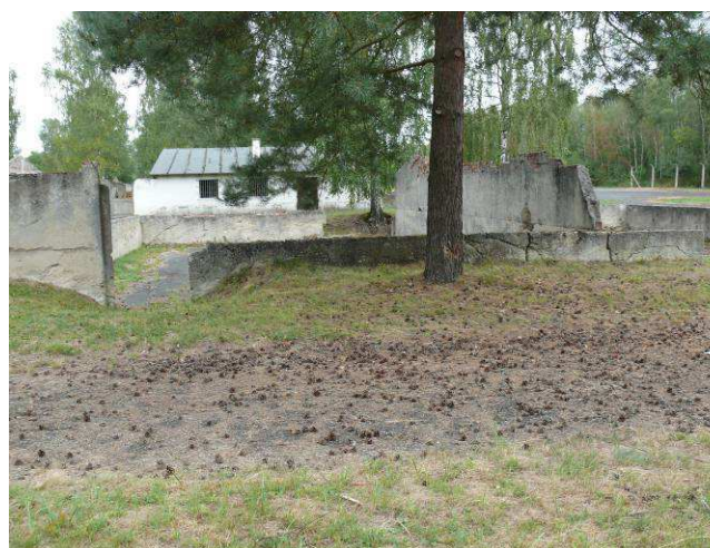
Widok na ścianę zewnętrzną strona południowa.
