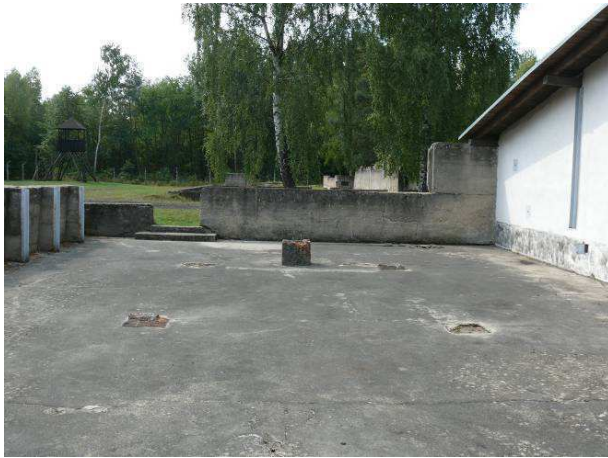
Widok na ścianę wewnętrzną strona południowa.
