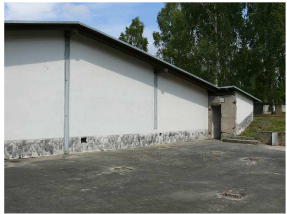
Widok na ścianę wewnętrzną strona zachodnia.
