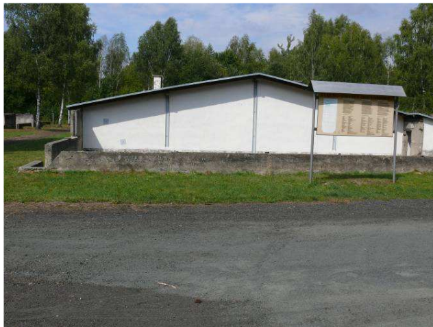
Widok na ścianę zewnętrzną strona wschodnia.
