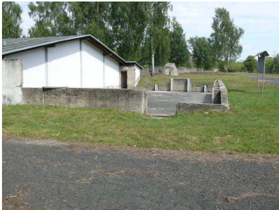
Widok na ścianę zewnętrzną strona południowa.
