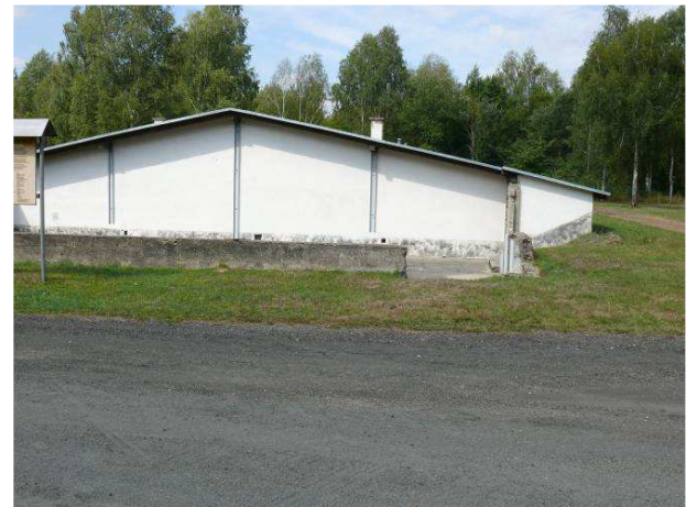
Widok na ścianę zewnętrzną strona wschodnia.
