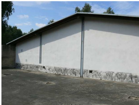
Widok na ścianę wewnętrzną strona zachodnia.
