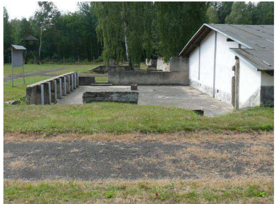
Widok na ścianę zewnętrzną strona północna.
