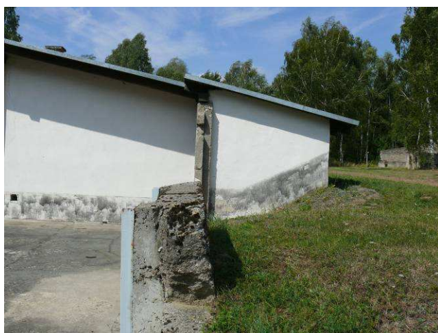
Widok na ścianę zewnętrzną strona wschodnia – latryna.
