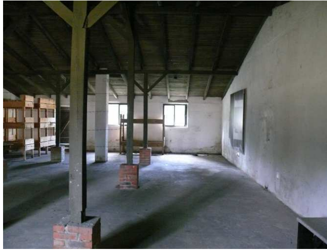
Widok na ścianę wewnętrzną strona południowo-zachodnia.
