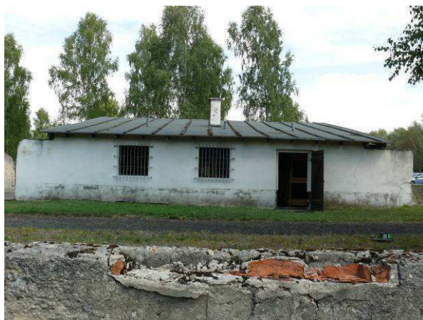
Widok na ścianę zewnętrzną strona południowa.
