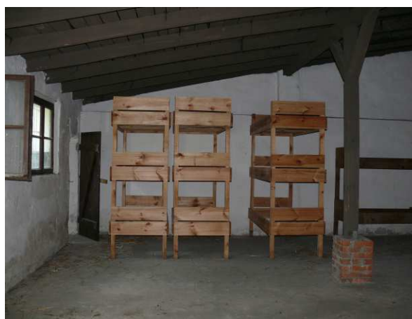
Widok na ścianę wewnętrzną strona wschodnio-północna.
