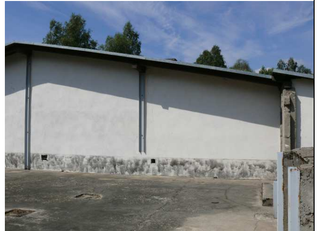
Widok na ścianę zewnętrzną strona wschodnia.
