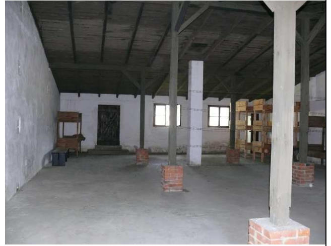
Widok na ścianę wewnętrzną strona północna.
