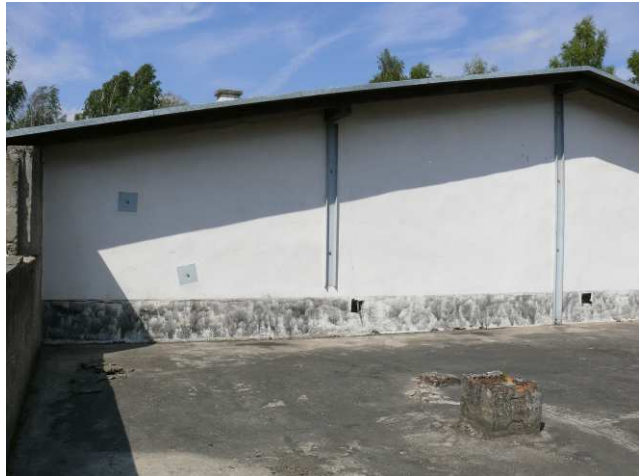
Widok na ścianę zewnętrzną strona wschodnia.
