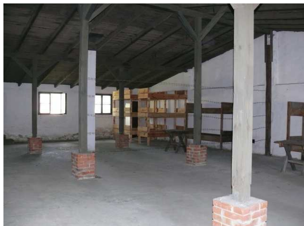
Widok na ścianę wewnętrzną strona północno-wschodnia.
