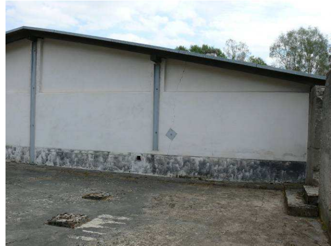
Widok na ścianę zewnętrzną strona zachodnia.
