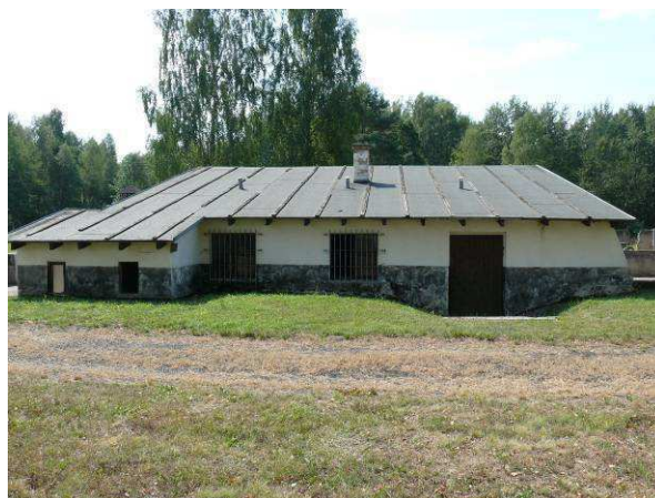
Widok na ścianę zewnętrzną strona północna.
