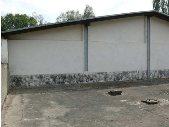
Widok na ścianę zewnętrzną strona zachodnia.
