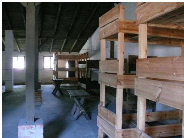
Widok na ścianę wewnętrzną strona północno-wschodnia.
