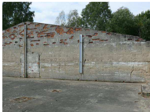
Widok na ścianę wewnętrzną strona zachodnia.
