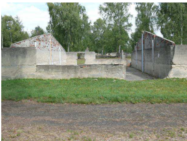
Widok na ścianę zewnętrzną strona południowa.
