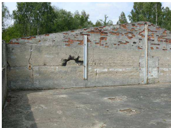
Widok na ścianę wewnętrzną strona zachodnia.
