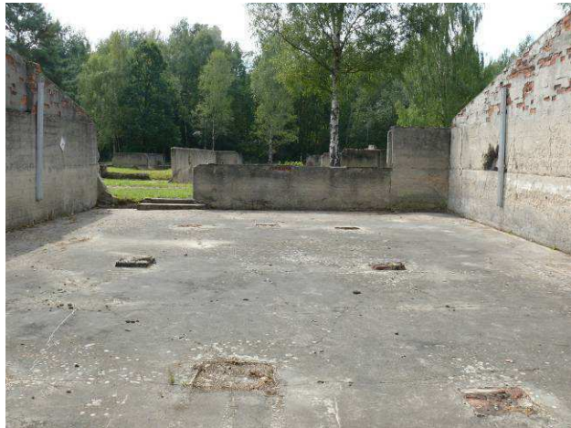
Widok na ścianę wewnętrzną strona południowa.
