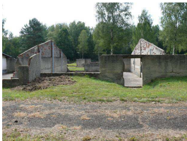
Widok na ścianę zewnętrzną strona północna.
