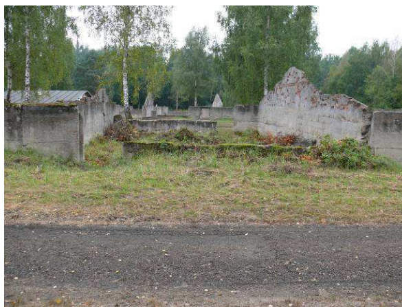
Widok na ścianę zewnętrzną strona północna.
