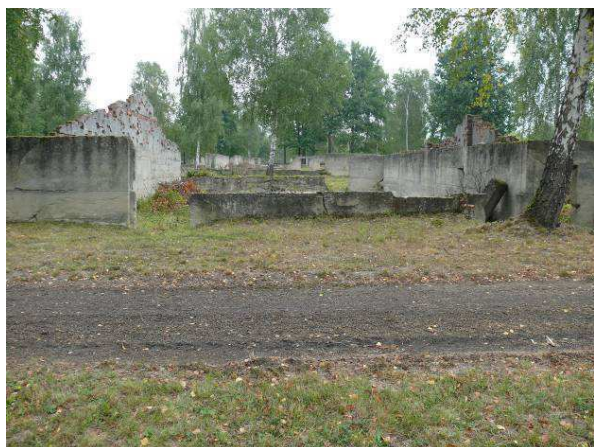
Widok na ścianę zewnętrzną strona południowa.
