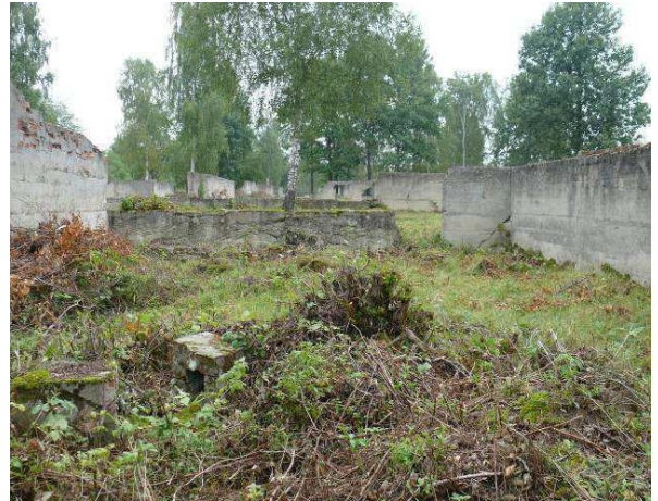
Widok na ścianę wewnętrzną strona północna.
