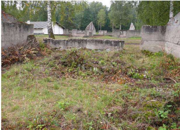
Widok na ścianę wewnętrzną strona południowa.
