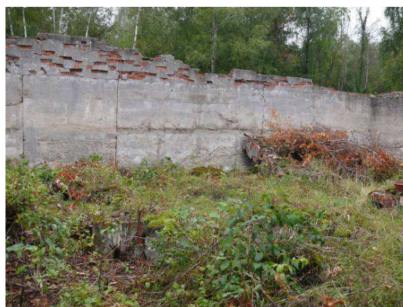
Widok na ścianę wewnętrzną strona zachodnia.
