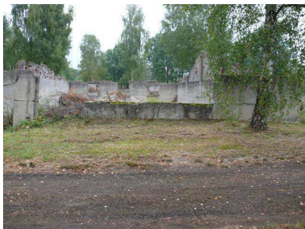
Widok na ścianę zewnętrzną strona południowa.
