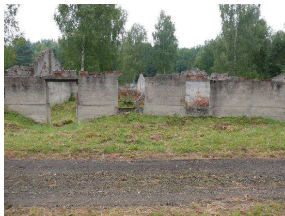
Widok na ścianę zewnętrzną strona północna.
