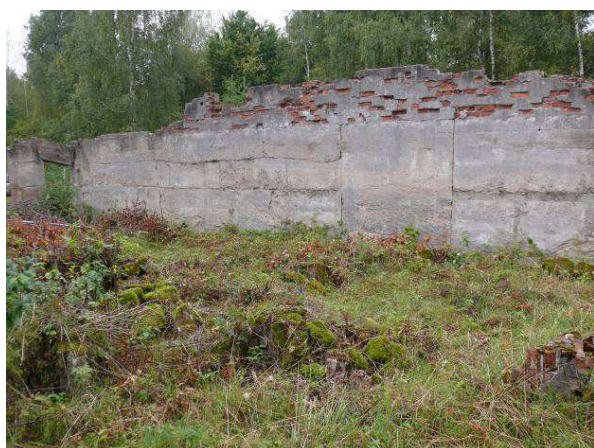
Widok na ścianę wewnętrzną strona zachodnia.
