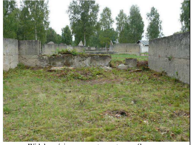
Widok na ścianę wewnętrzną strona północna.
