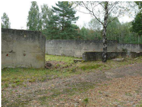
Widok na ścianę zewnętrzną strona południowa.
