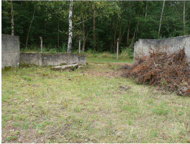
Widok na ścianę wewnętrzną strona południowa.
