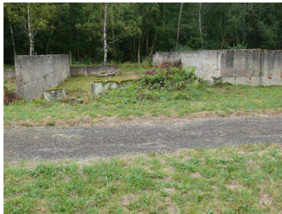
Widok na ścianę zewnętrzną strona północna.
