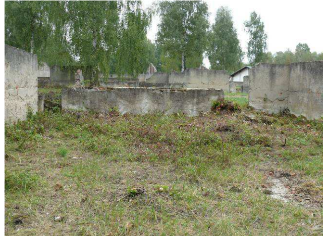
Widok na ścianę wewnętrzną stronę północną.
