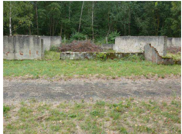
Widok na ścianę zewnętrzną strona północna.
