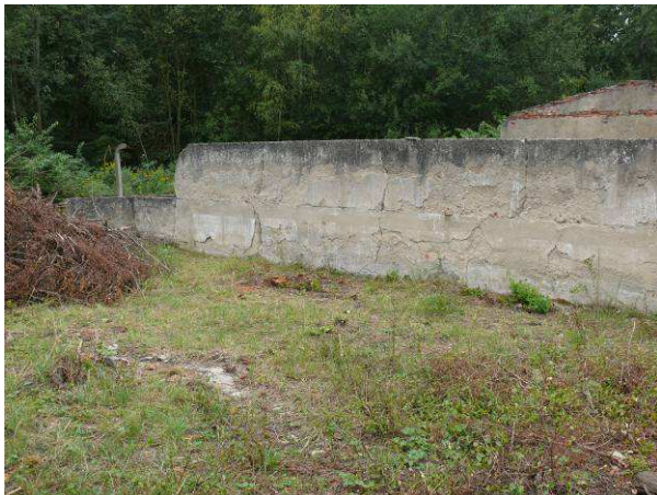
Widok na ścianę wewnętrzną strona zachodnia.
