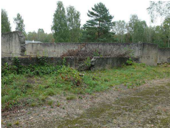
Widok na ścianę zewnętrzną strona południowa.
