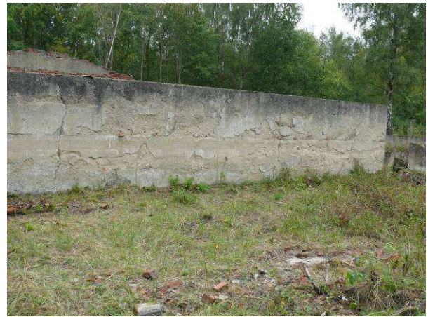
Widok na ścianę wewnętrzną strona zachodnia.
