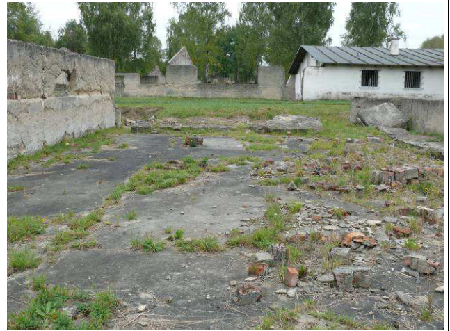
Widok na ścianę wewnętrzną strona północna.
