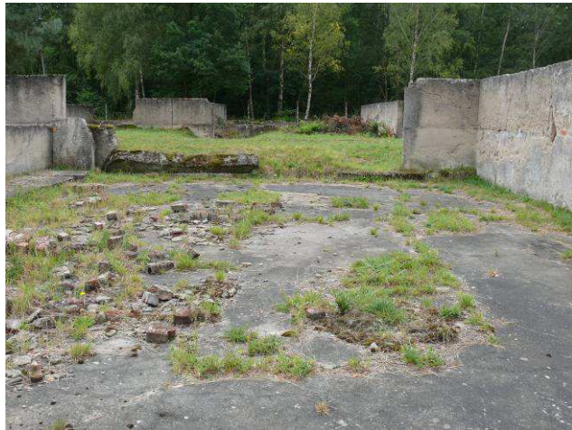
Widok na ścianę wewnętrzną strona południowa.
