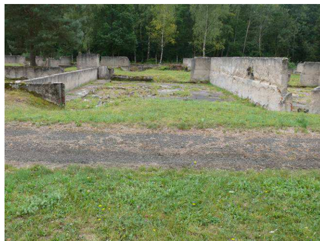
Widok na ścianę zewnętrzną strona północna.
