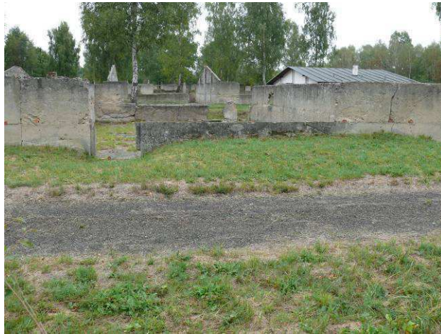
Widok na ścianę zewnętrzną strona południowa.
