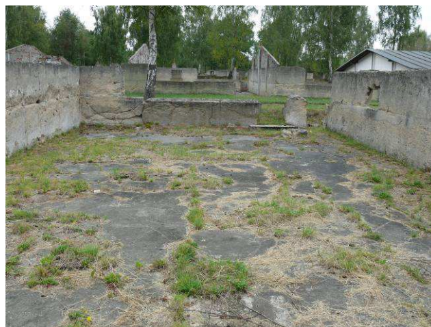
Widok na ścianę wewnętrzną strona północna.
