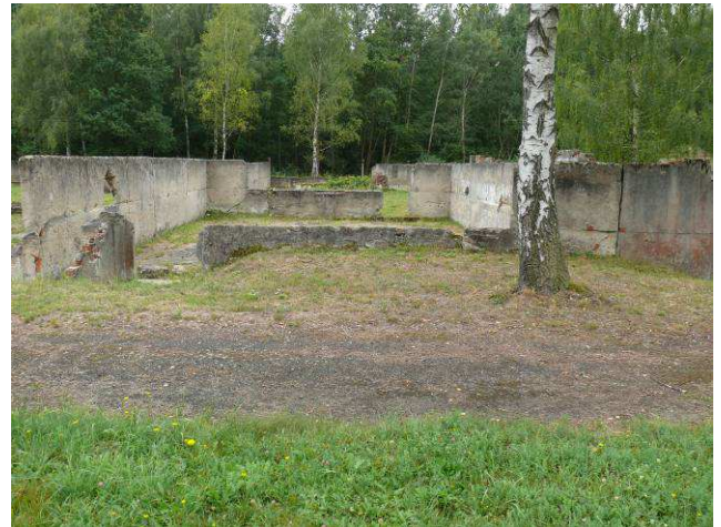
Widok na ścianę zewnętrzną strona północna.
