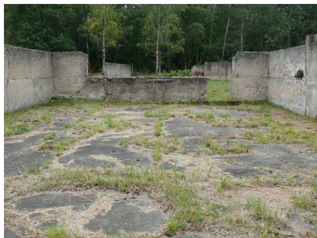
Widok na ścianę wewnętrzną strona południowa.
