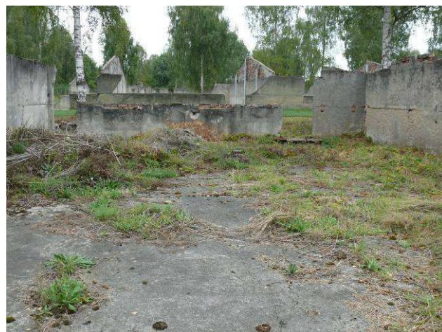
Widok na ścianę wewnętrzną strona północna.
