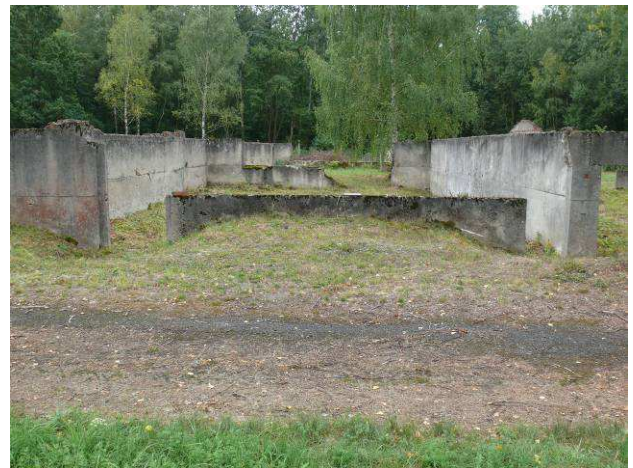
Widok na ścianę zewnętrzną strona północna.
