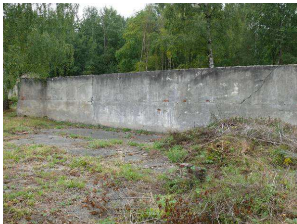
Widok na ścianę wewnętrzną strona zachodnia.
