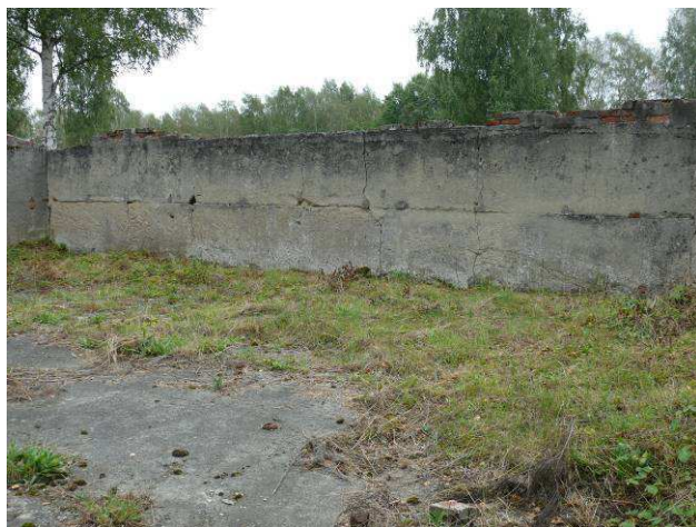
Widok na ścianę wewnętrzną strona wschodnia.
