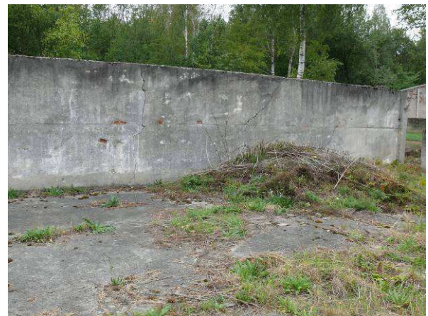
Widok na ścianę wewnętrzną strona zachodnia.
