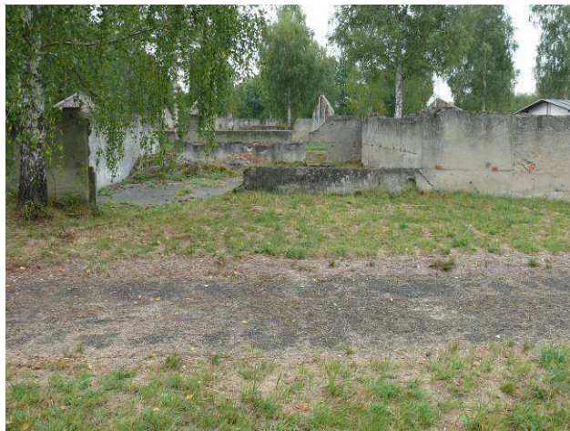
Widok na ścianę zewnętrzną strona południowa.
