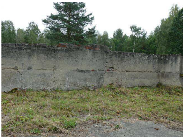
Widok na ścianę wewnętrzną strona wschodnia.
