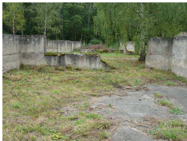
Widok na ścianę wewnętrzną strona południowa.
