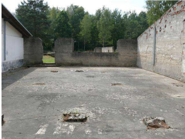
Widok na ścianę wewnętrzną strona południowa.
