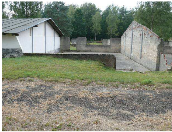
Widok na ścianę zewnętrzną strona północna.
