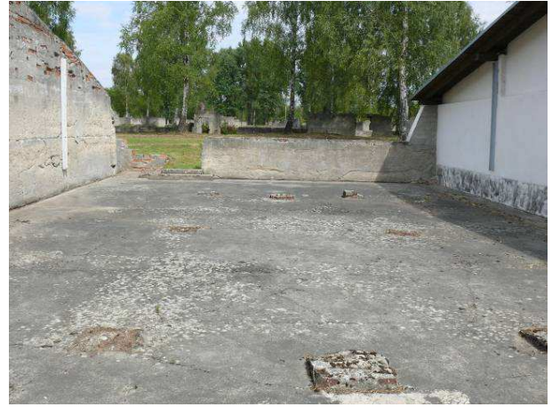
Widok na ścianę wewnętrzną strona północna.
