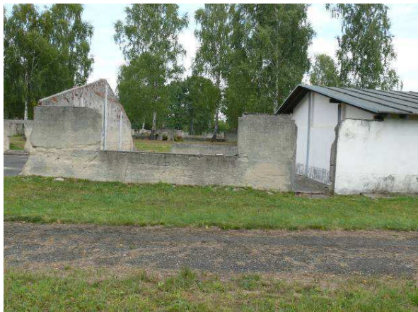
Widok na ścianę zewnętrzną strona południowa.
