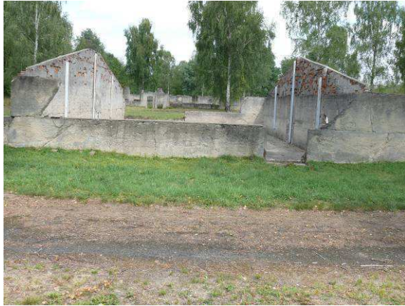
Widok na ścianę zewnętrzną strona południowa.
