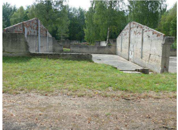
Widok na ścianę zewnętrzną strona północna.
