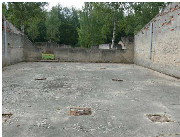
Widok na ścianę wewnętrzną strona południowa.
