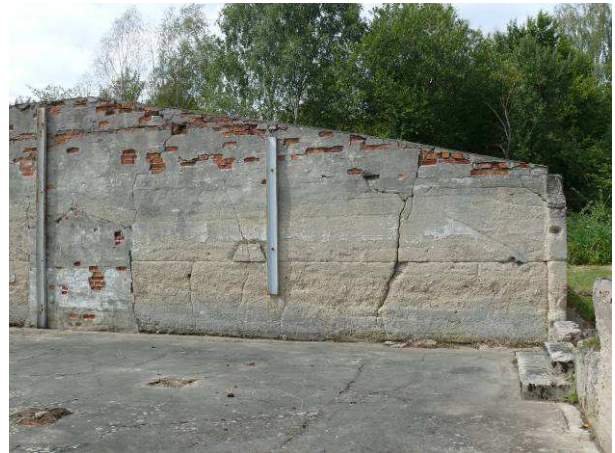
Widok na ścianę wewnętrzną strona zachodnia.
