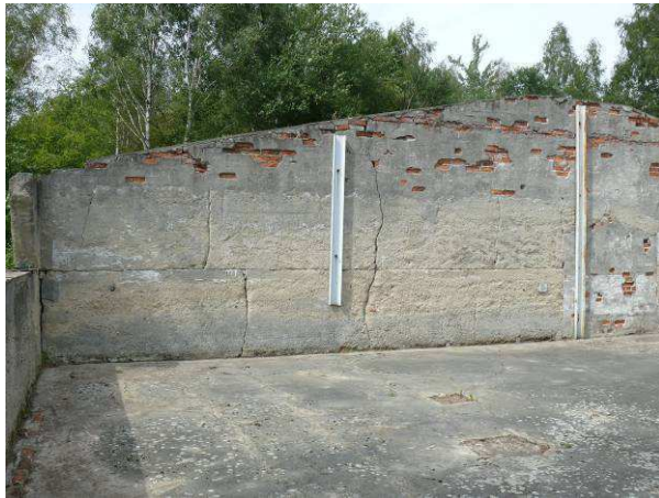
Widok na ścianę wewnętrzną strona zachodnia.
