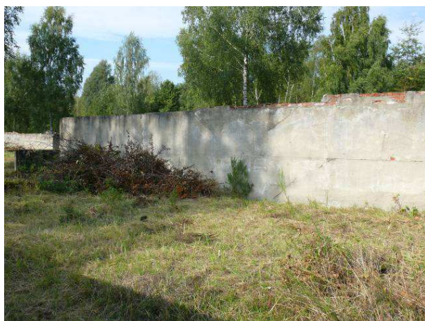
Widok na ścianę wewnętrzną strona zachodnia.
