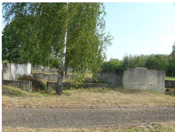
Widok na ścianę zewnętrzną strona południowa.
