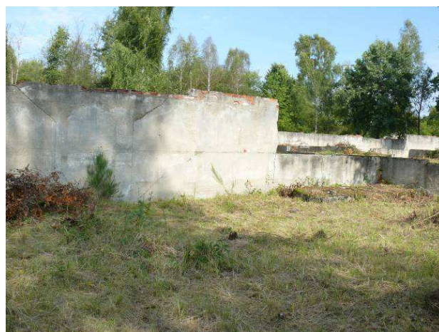
Widok na ścianę wewnętrzną strona zachodnia.
