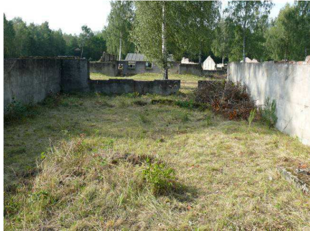
Widok na ścianę wewnętrzną strona południowa.
