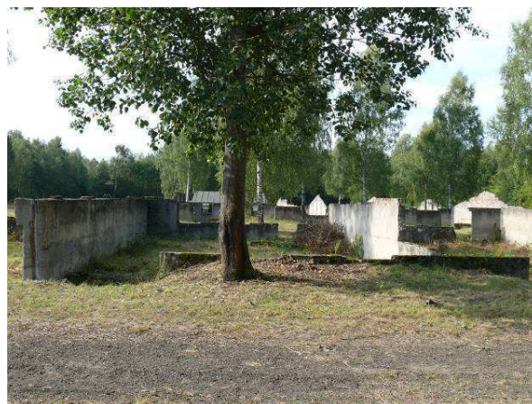
Widok na ścianę zewnętrzną strona północna.
