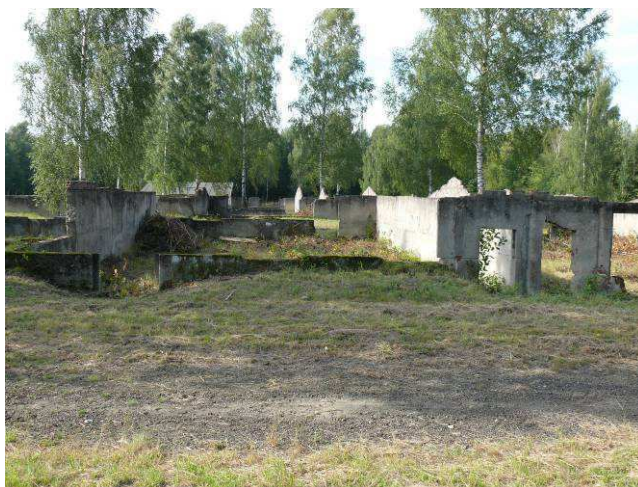
Widok na ścianę zewnętrzną strona północna.
