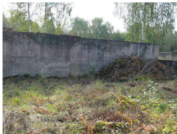
Widok na ścianę wewnętrzną strona wschodnia.
