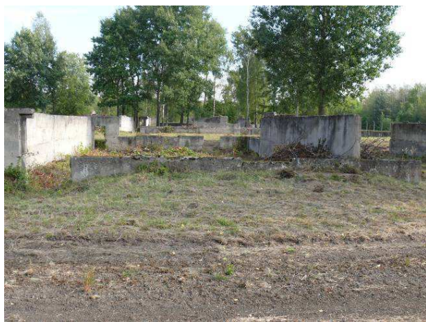
Widok na ścianę zewnętrzną strona południowa.
