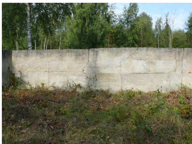
Widok na ścianę wewnętrzną strona zachodnia.
