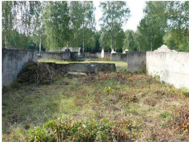
Widok na ścianę wewnętrzną strona południowa.
