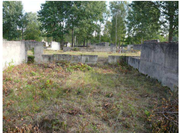
Widok na ścianę wewnętrzną strona północna.
