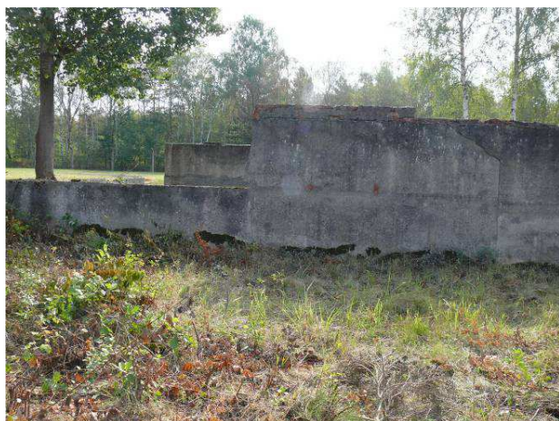
Widok na ścianę wewnętrzną strona wschodnia.
