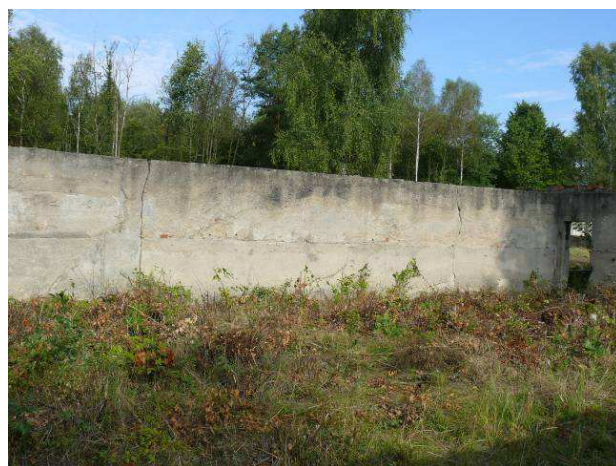
Widok na ścianę wewnętrzną strona zachodnia.
