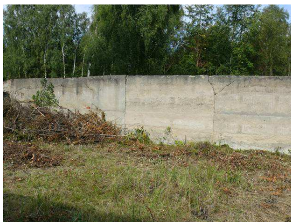
Widok na ścianę wewnętrzną strona zachodnia.
