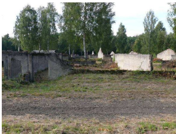
Widok na ścianę zewnętrzną strona północna.
