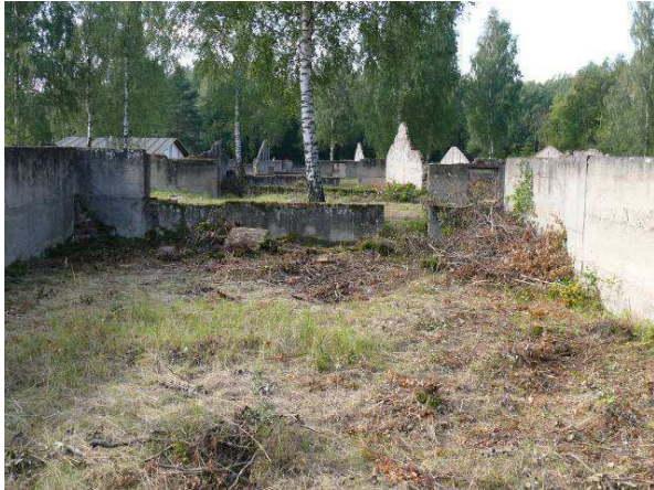
Widok na ścianę wewnętrzną strona południowa.
