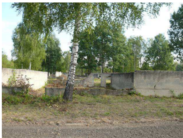
Widok na ścianę zewnętrzną strona południowa.
