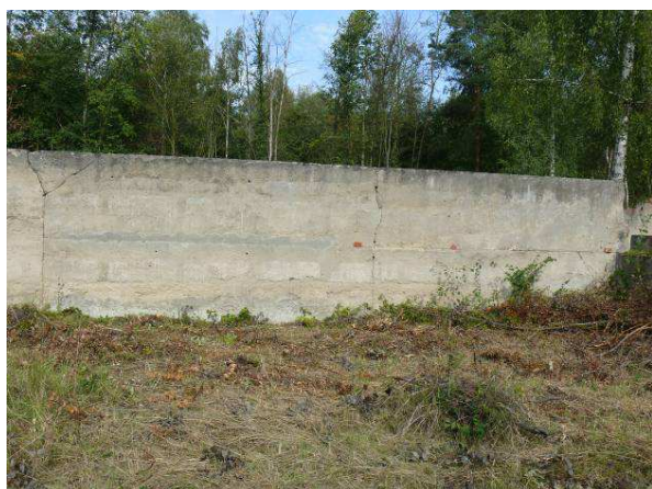
Widok na ścianę wewnętrzną strona zachodnia.
