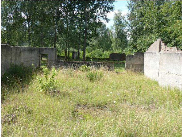
Widok na ścianę wewnętrzną strona południowa.
