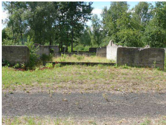
Widok na ścianę zewnętrzną strona północna.
