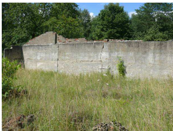
Widok na ścianę wewnętrzną strona zachodnia.
