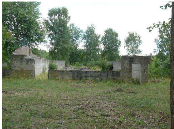
Widok na ścianę zewnętrzną strona południowa.
