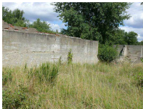
Widok na ścianę wewnętrzną strona zachodnia.
