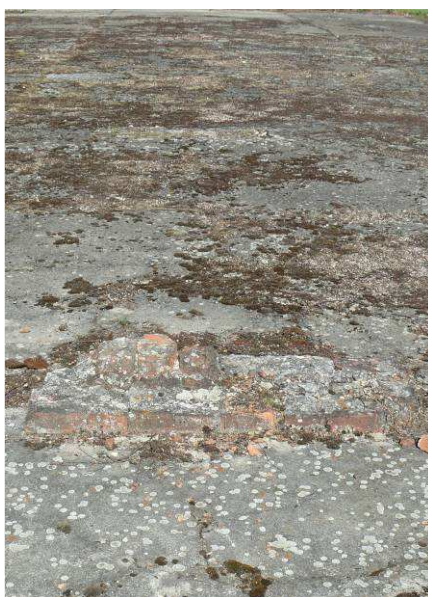
Pozostałości po trzonach kominowych
