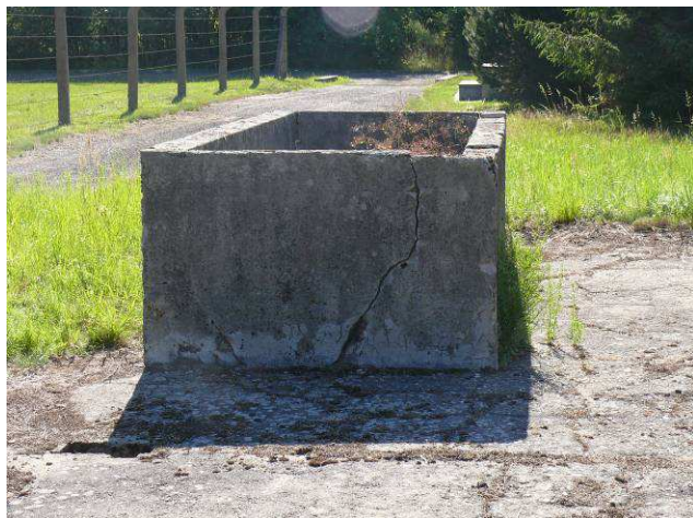
Zbiornik jednokomorowy - naroże północno-wschodnie
