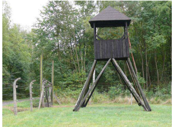
Widok od strony północnej
